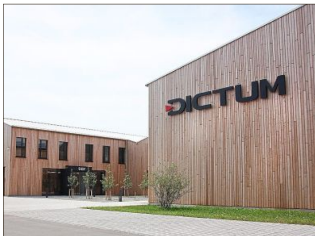
Die Fassade der Firma Dictum in Plattling ist vollständig mit Holz verkleidet.
