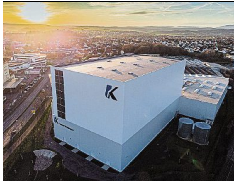
Das neue Hochregallager ist 42 Meter hoch.
